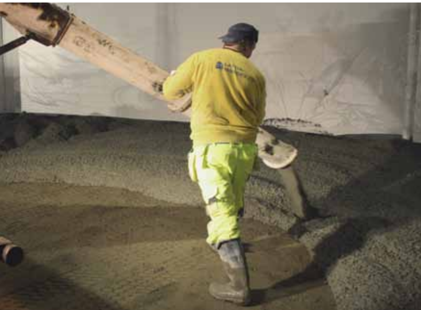
Kuitubetonia käyttäen valutyö helpottuu.
